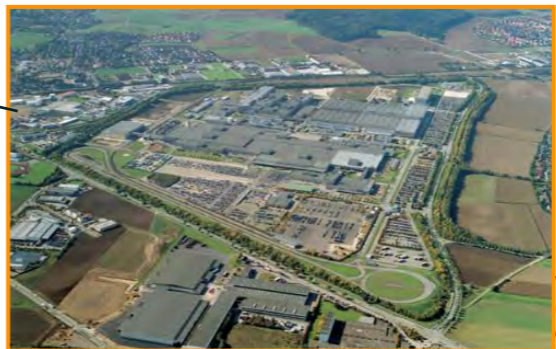
vue aérienne du site BMW (source: https://www.ths-ug-deggendorf.com/referenzen/ )
