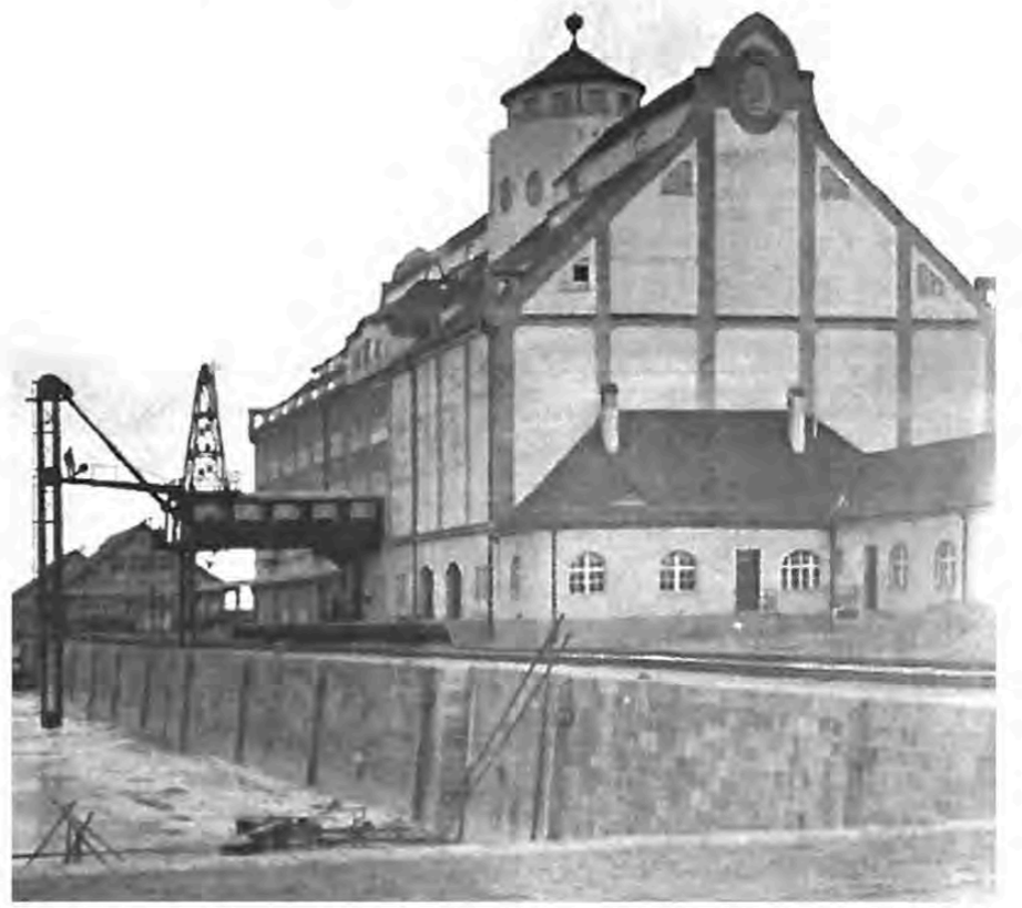
Imagenes antiguas del Stadtlagerhaus
