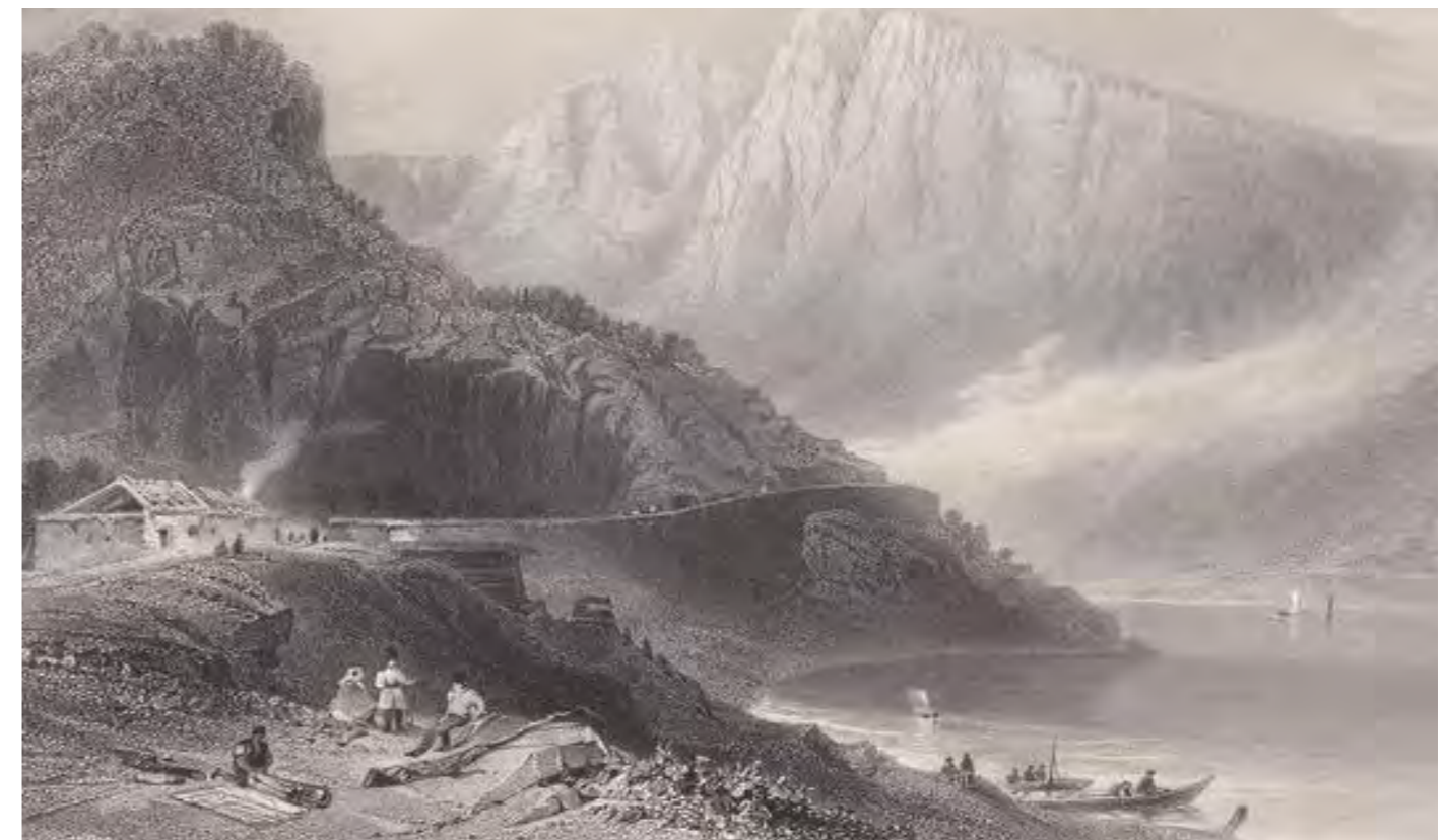
Vue des portes de Fer au niveau des Carpates. 1850. Gravure en acier [En ligne]. < http://www.zvab.com > (page consultée le 17 Février 2018).
