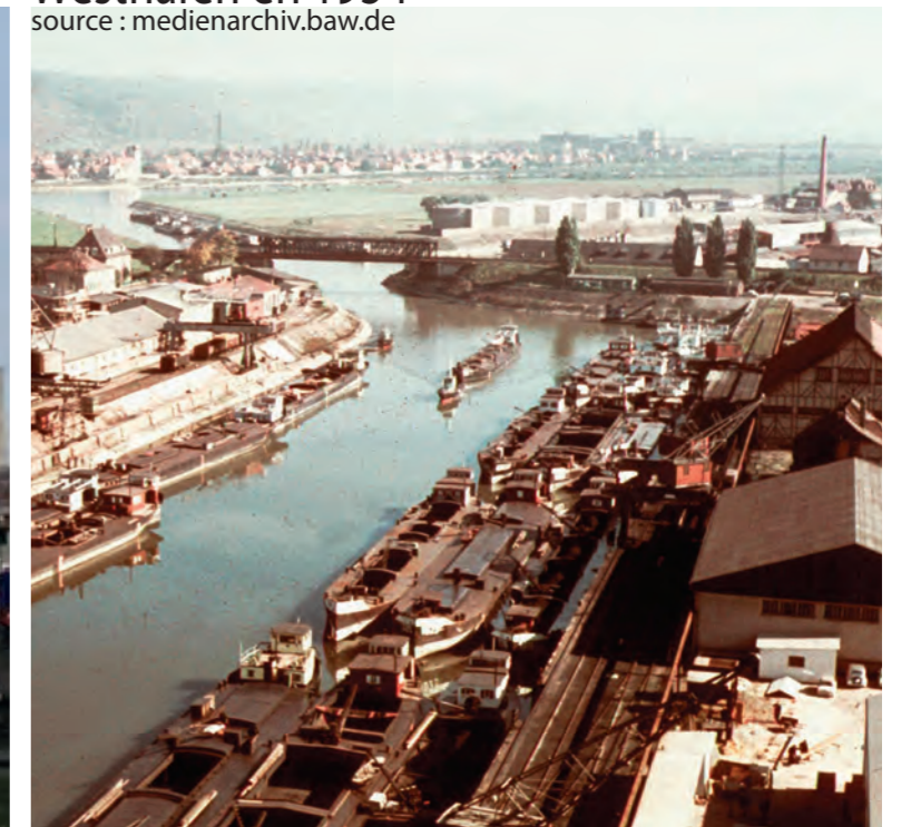
Activités et constructions autour du Westhafen vu depuis la tour du Stadtlagerhaus
