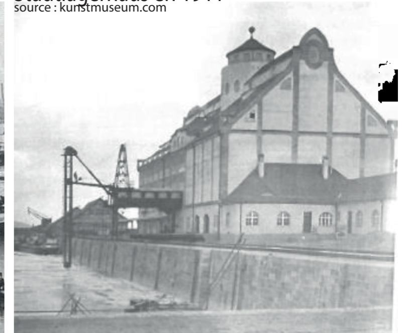
Premier bâtiment administratif accolé à l'extrémité Ouest du Luitpoldhafen - Premier système de grue
