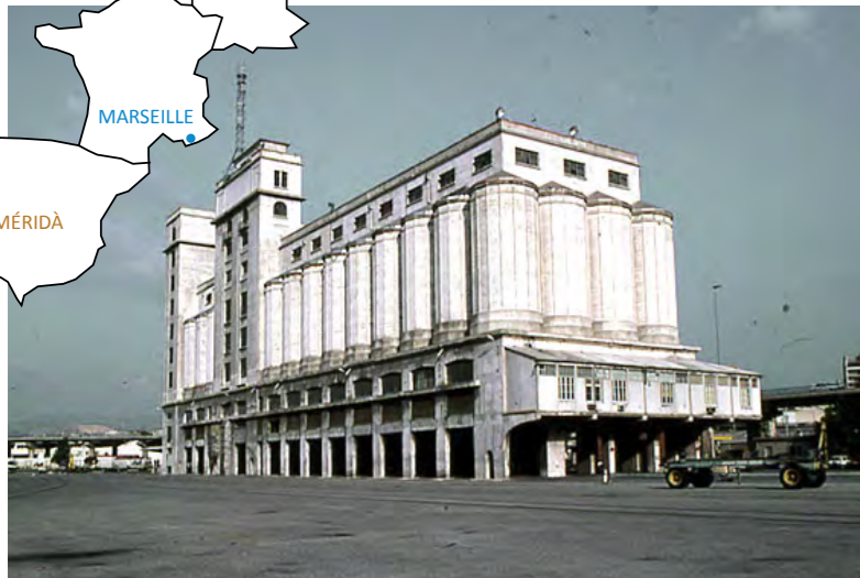
1920-27 | Le silo d'Arenc - Marseille - FRANCE
