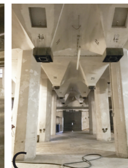
C Trémies en béton qui gé- nèrent une oppression
