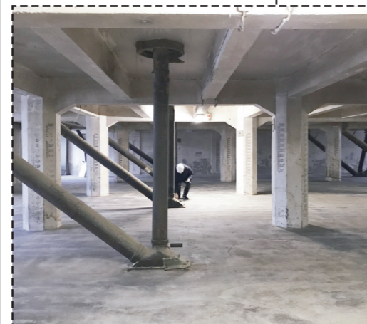
Niveau intermédiaire du Stadtlagerhaus
