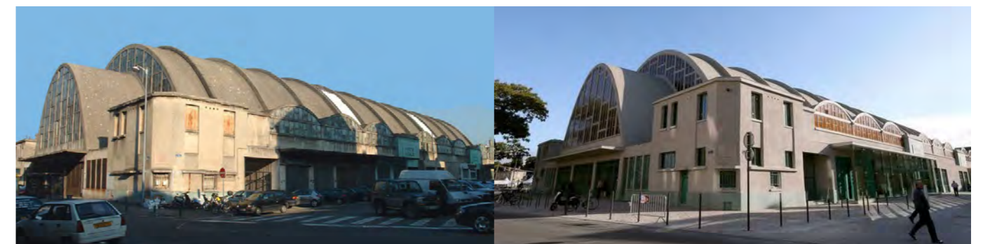
Une façade modernisée dans le respect de la matérialité d'origine
