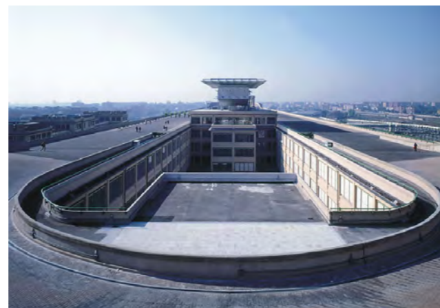
Vue toiture de l'extension/ Extension 2002
