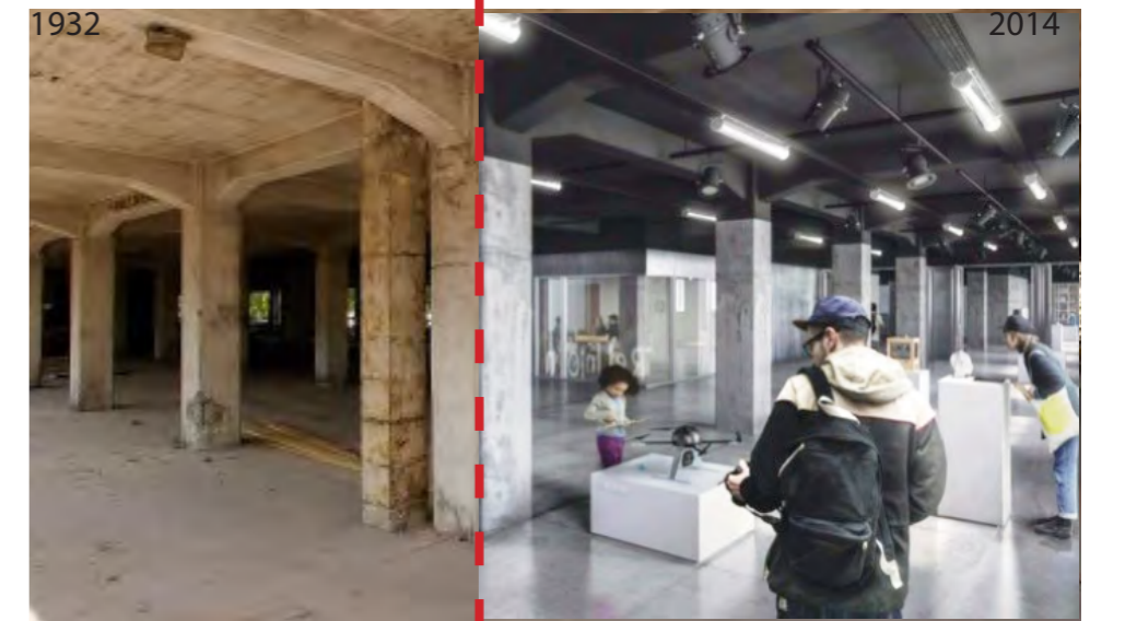
Conservation et appui sur la trame existante du rdc pour faire la surélévation tout en préservant la qualité des plateaux libres (poteaux/poutres)
