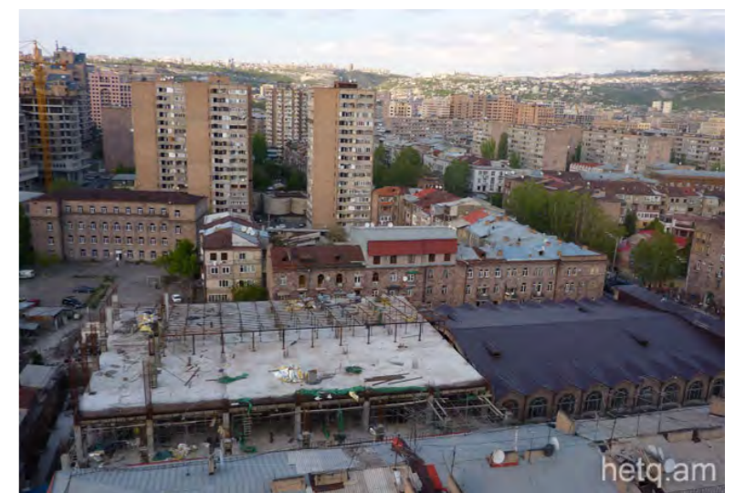
Mixité radicale de deux époques et deux valeurs architecturales
